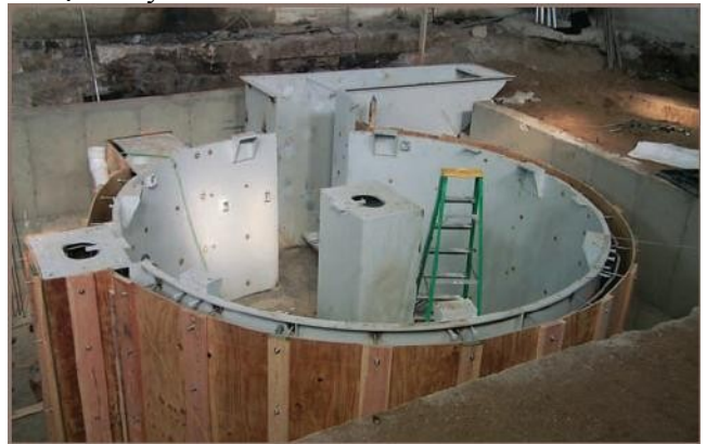
Thi công hầm máy có mâm quay theo chiều kim đồng hồ, sử dụng các tấm thép làm vỏ hầm và cầu thang xuống hầm làm giảm chi phí cốp pha cũng như chi phí lắp đặt
